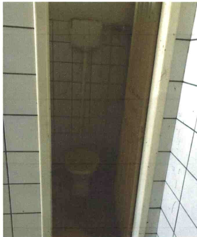
Figura 7: vista interna vestiário, detalha sanitário.
