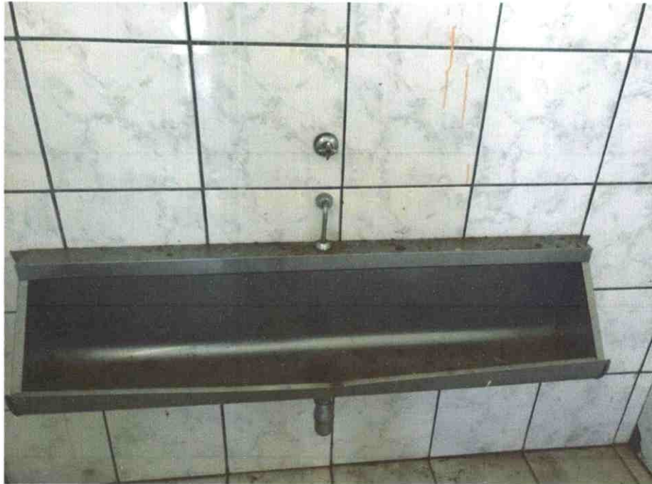
Figura 6: vista interna banheiro, detalhe mictório.
