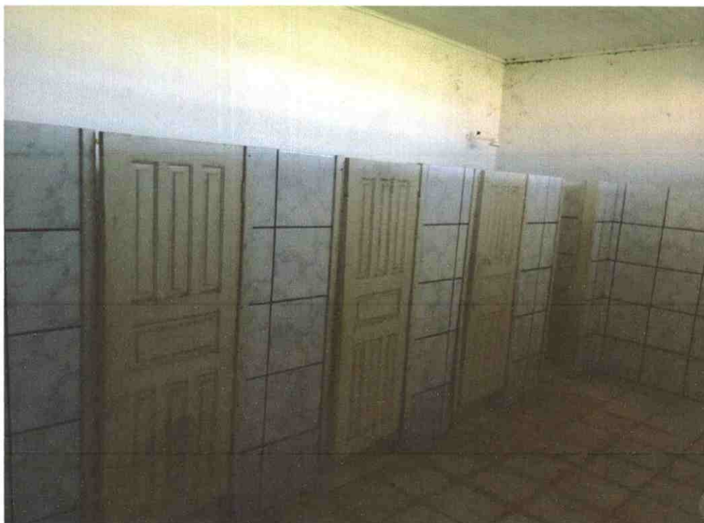
Figura 2: vista interna banheiro.
