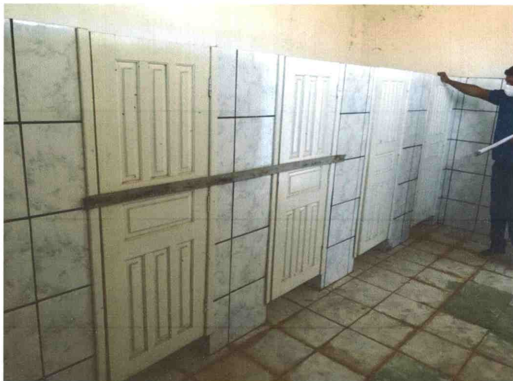
Figura 4: vista interna banheiro, detalhe piso e portas dos sanitários.
