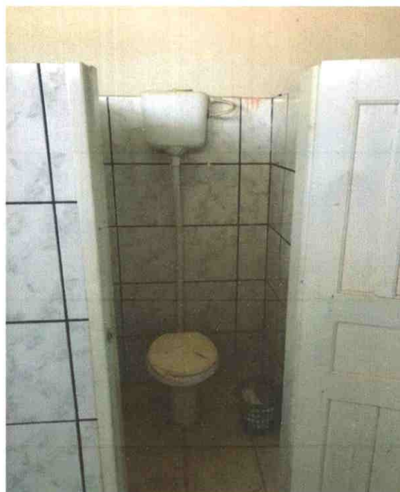
Figura 5: vista interna banheiro.
