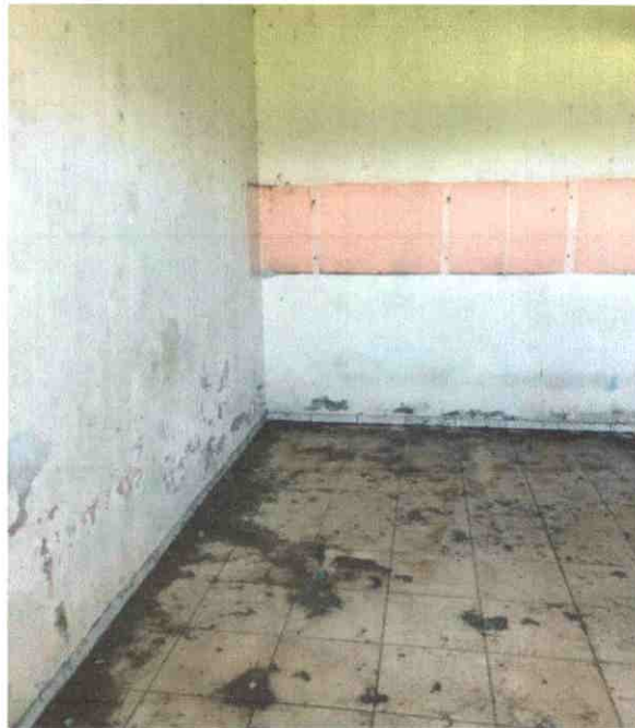
Figura 8: vista interna vestiário.
