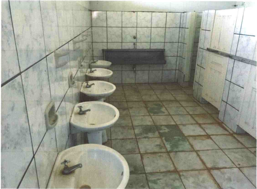
Figura 9: vista interna banheiro.
