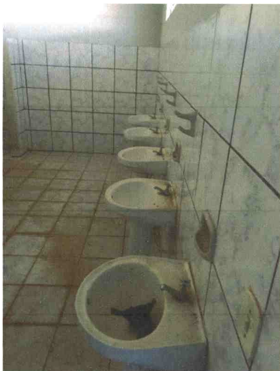
Figura 1 : vista interna banheiros, pias em detalhe.
